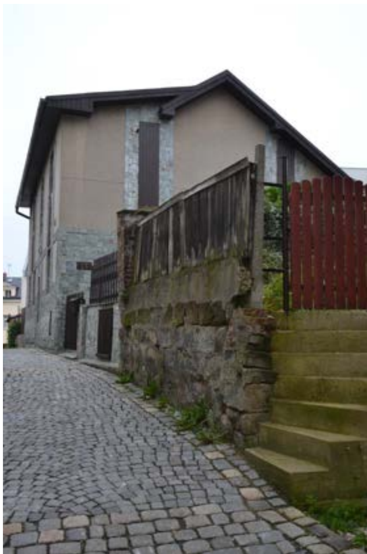
Východní průčelí domu č. p. 413, foto IP 2013.
