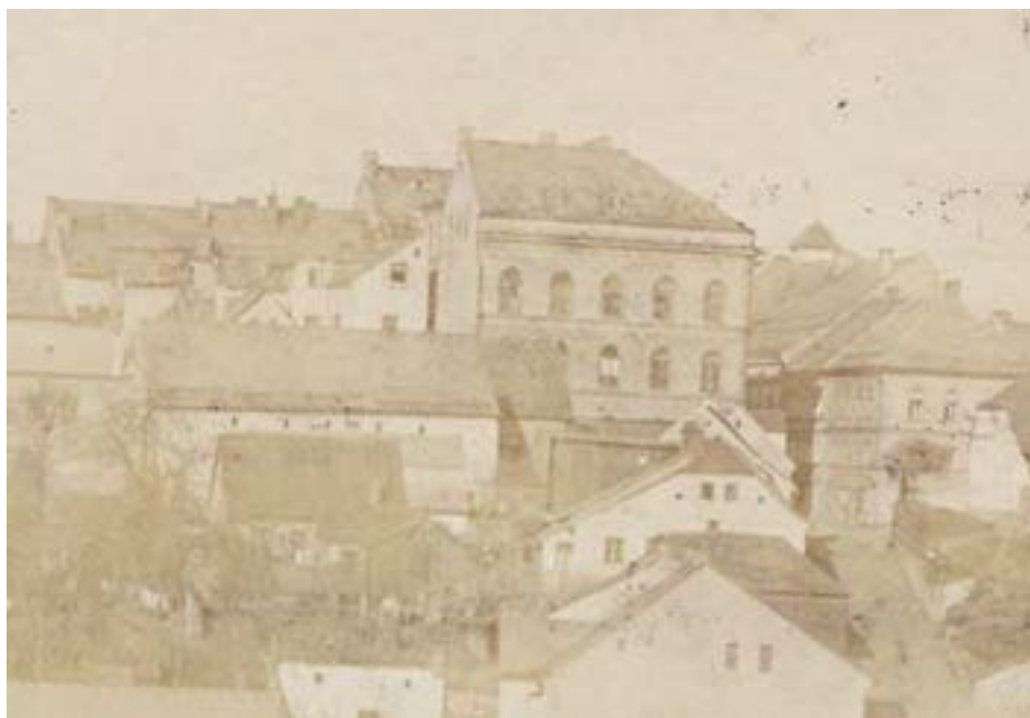
Zadní průčelí dvorního křídla domu č. p. 5, výřez z celkového pohledu na Markovu ulici, (foto sbírka MČR, inv. č. AFT 415)
