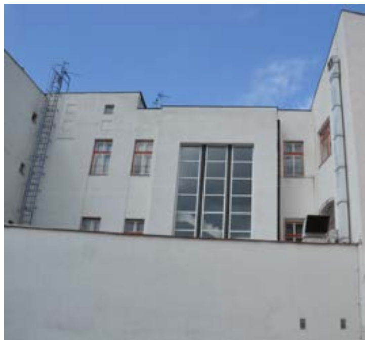
Zadní východní průčelí domu č. p. 335, foto IP 2013.
