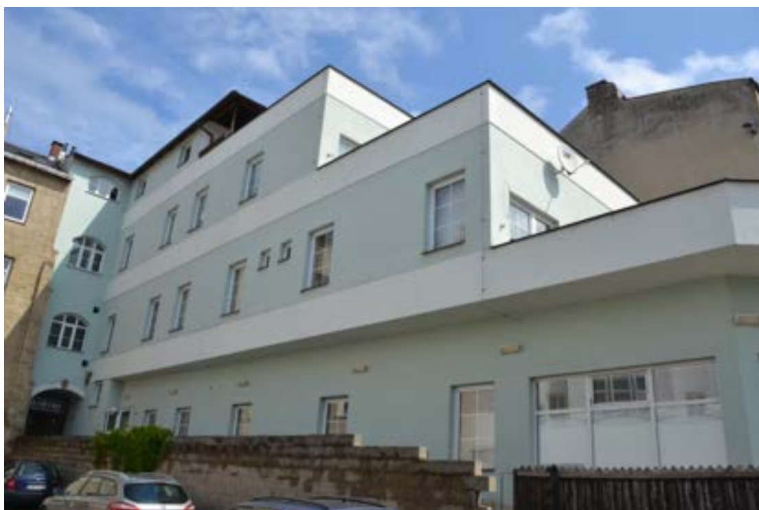
Celkový pohled od jihozápadu na zadní průčelí s dvorní novodobou přístavbou, foto IP 2013.
