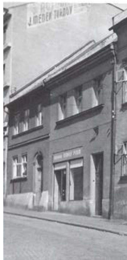
Štít domu č. p. 334 s reklamou v roce 1944, (foto sbírka MČR, inv. č. AFT 406).
