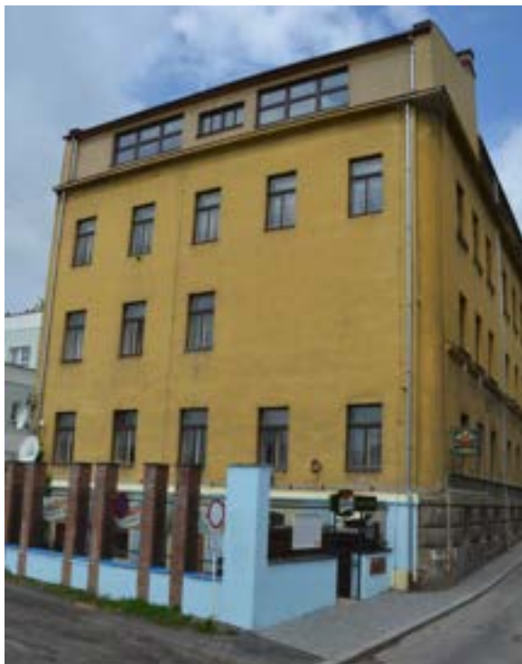
Zadní jižní průčelí domu, foto IP 2013.
