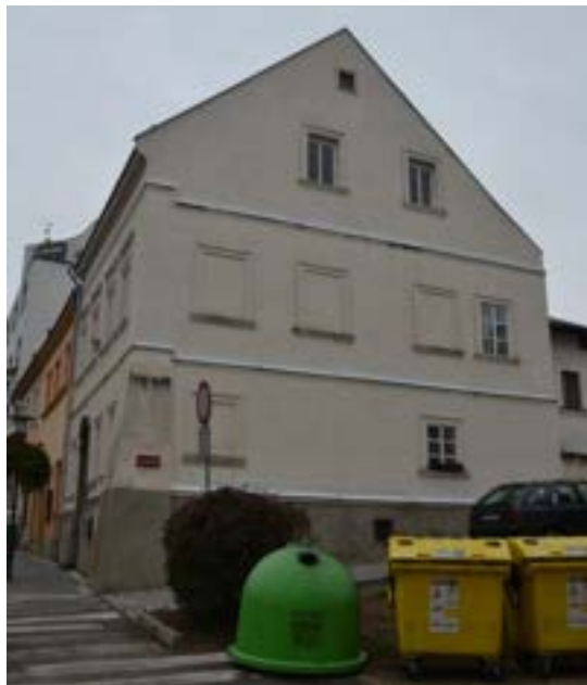
Jižní průčelí domu č. p. 331, foto IP 2013.
