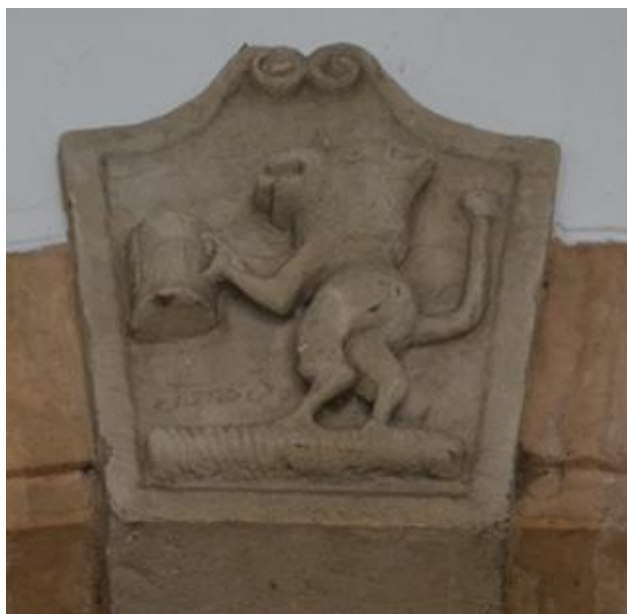
Detail hlavního klenáku portálu oddělující podloubí od průjezdu, pod korbelem vysekáno číslo domu 3., foto IP 2013.
