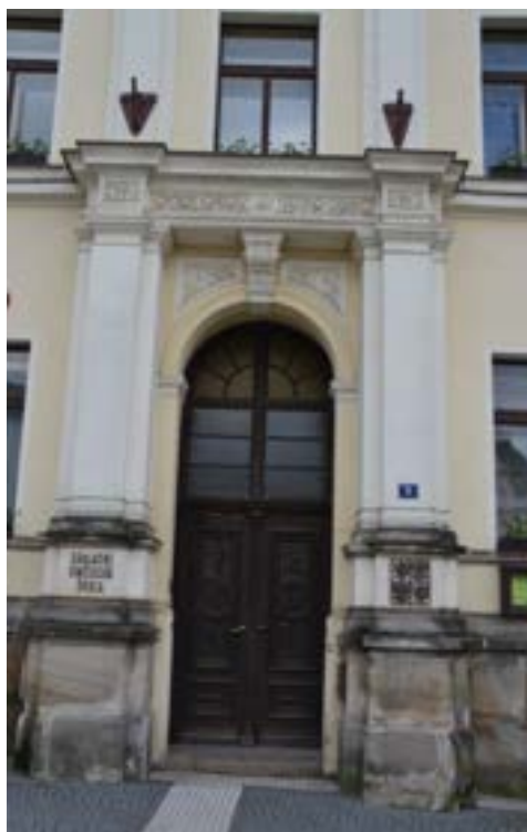
Vstupní portál domu, foto IP 2013.
