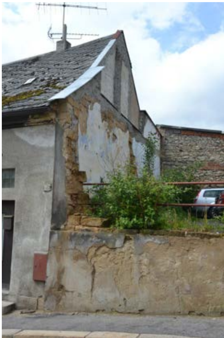
Pohled na torzo domu č. p. 6 po demolici, relikt jižní štítové zdi a soklová partie hlavního východního průčelí, foto IP 2013.
