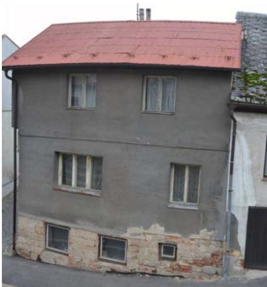
Dům č. p. 412, hlavní východní průčelí z nadhledu, foto IP 2013.
