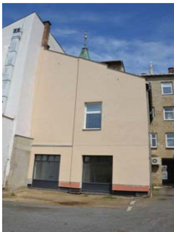
Dvorní průčelí přístavby, foto IP 2013.
