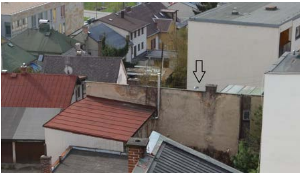
Pohled na střešní krajinu, dům č. p. 972 označen šipkou, foto TK 2013.
