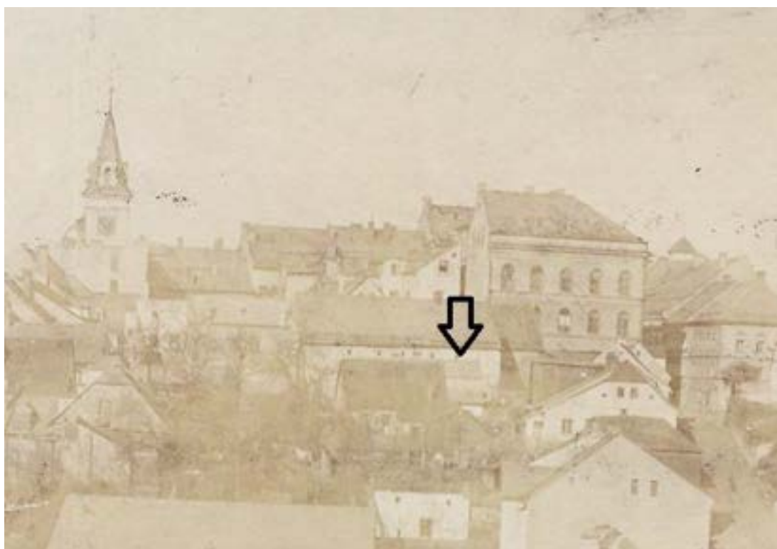
Výřez z celkového pohledu na Markovu ulici stoupající k náměstí, 1. pol. 20. století, mansardová střecha domu č. p. 413 vyznačena šipkou (foto sbírka MČR, inv. č. AFT 415).
