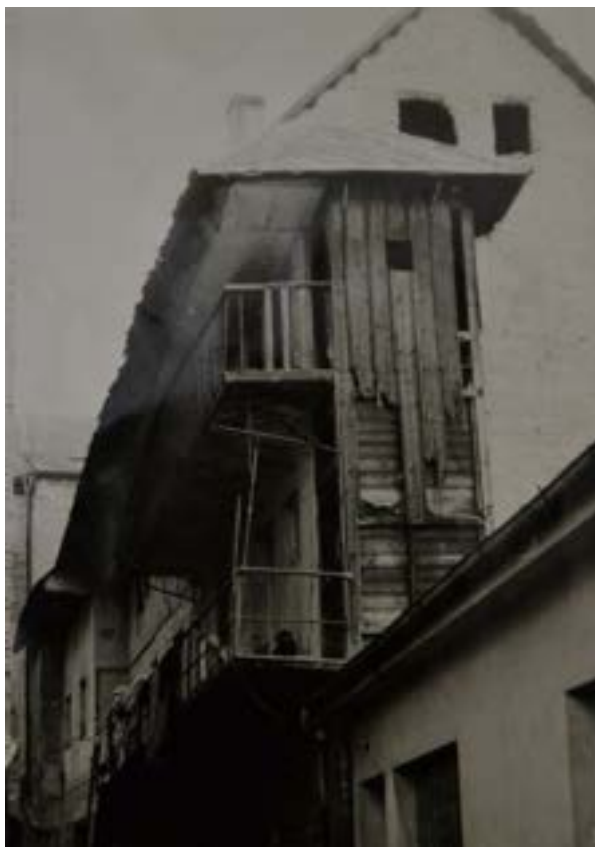
Pohled od jihu na podobu staré přístavby domu č. p. 3, konec 80. let 20. století, archiv Stavebního úřadu v Turnově.
