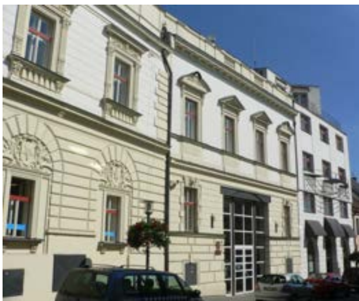
Západní průčelí, jižní část, foto MK 2013.
