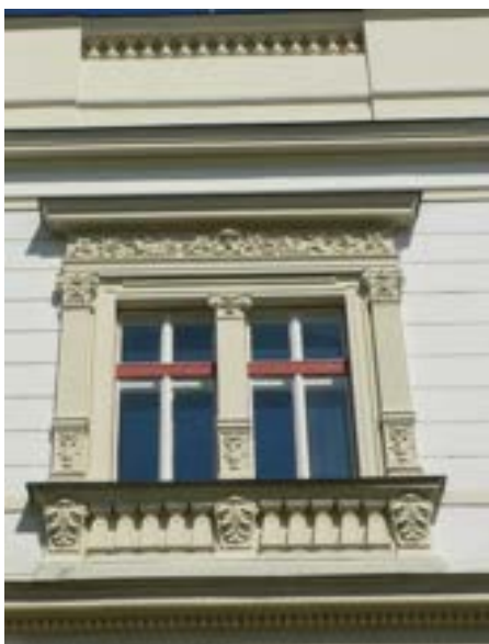
Detail okna v západním průčelí, foto MK 2013.
