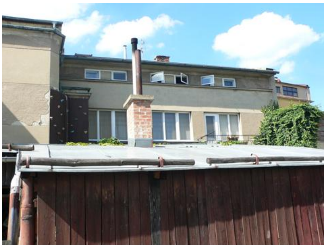
Jižní průčelí domu č. p. 972, foto MK 2013.
