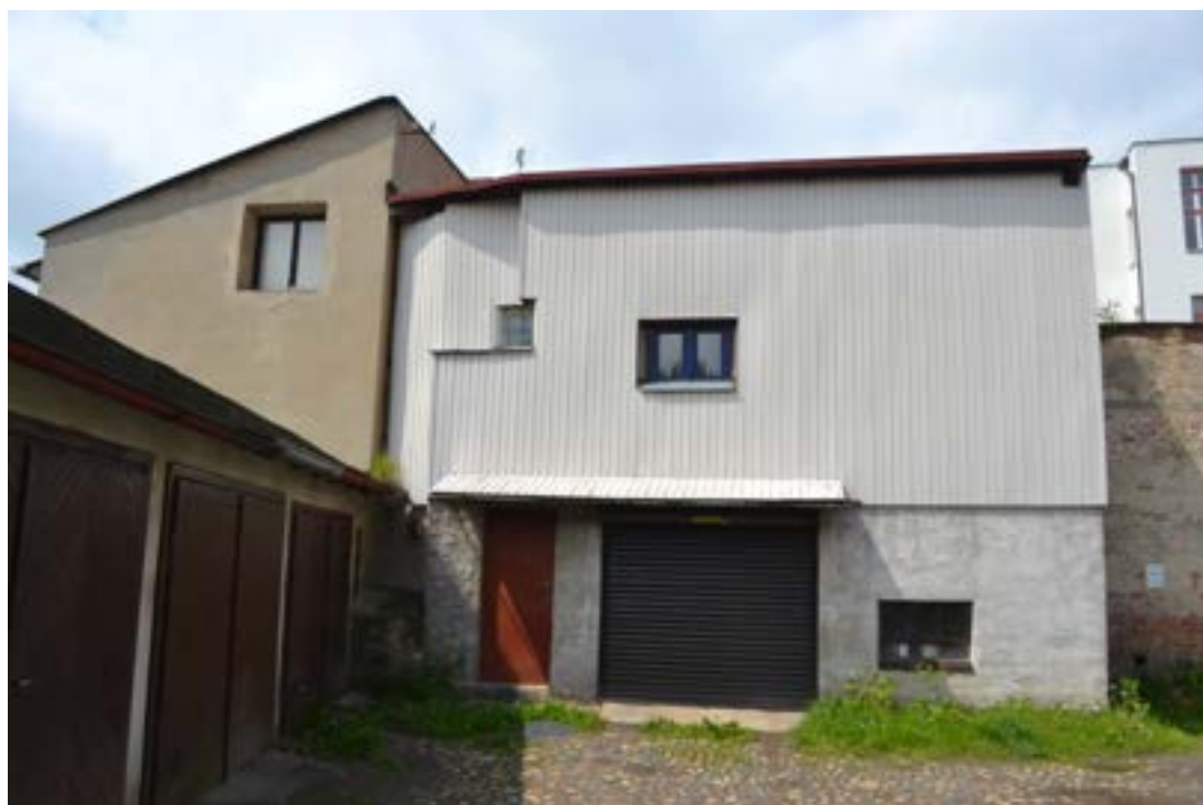
Východní průčelí domu č. p. 853, foto IP 2013.
