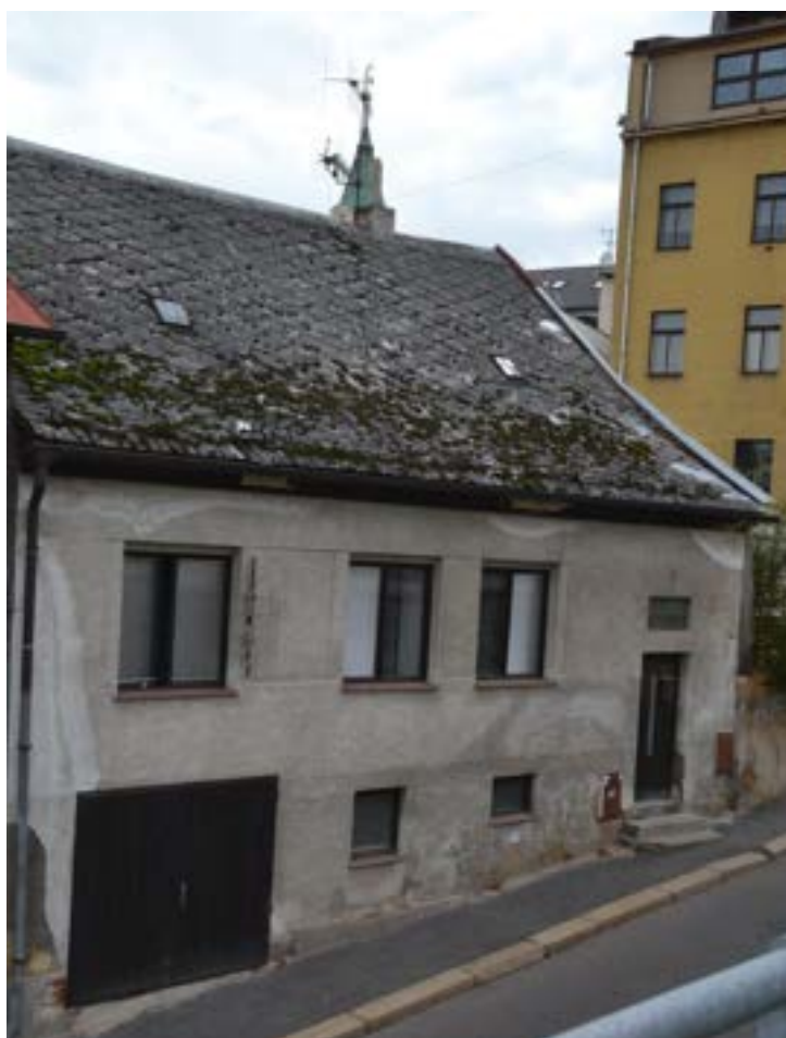
Východní hlavní průčelí a střecha domu č. p. 7, foto IP 2013.
