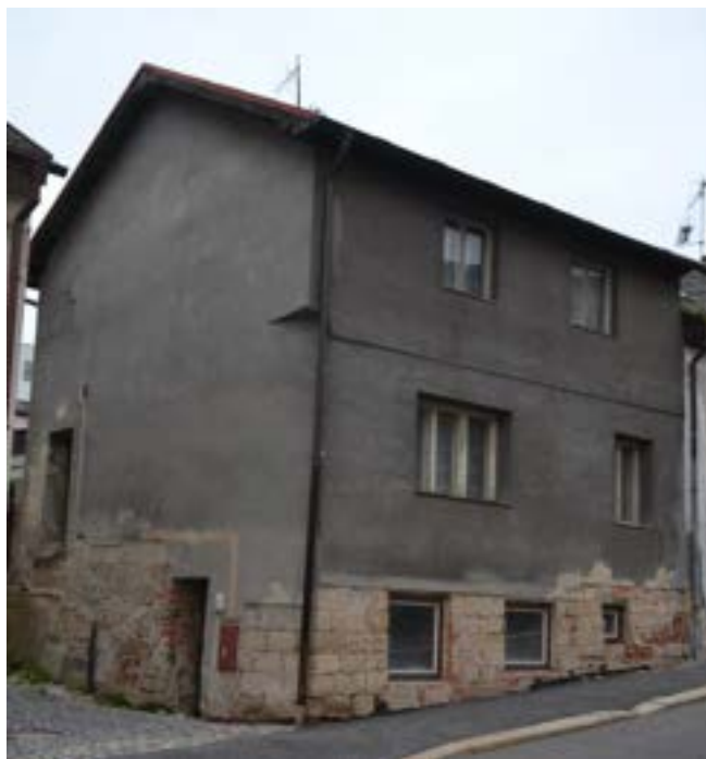
Dům č. p. 412, z podhledu dobře viditelný přesah nároží u druhého patra přistavěného v 2. polovině 20. století, foto IP 2013.
