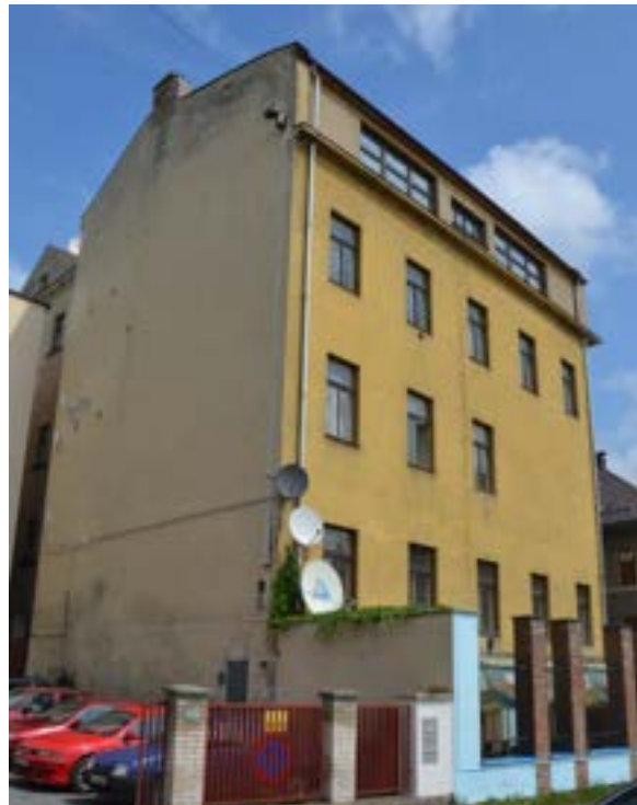
Jihozápadní nároží domu, foto IP 2013.
