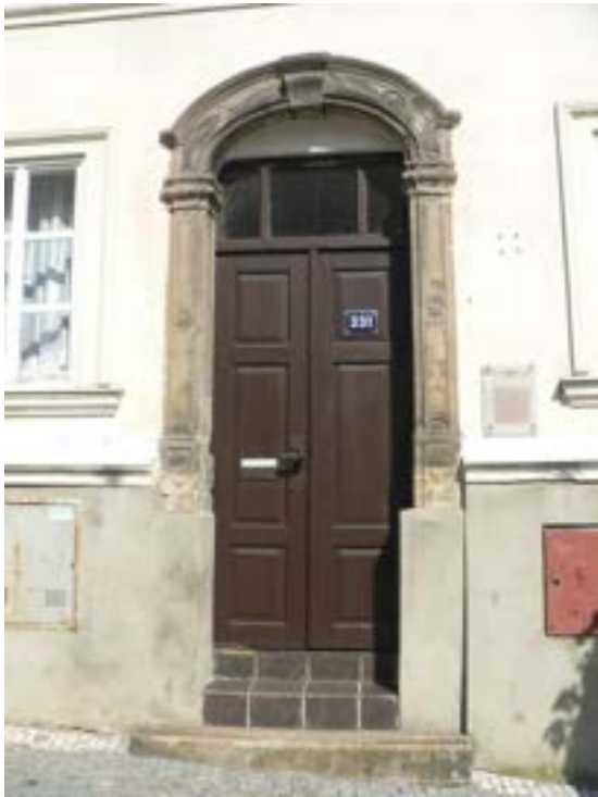
Portál domu č. p. 331, foto MK 2013.
