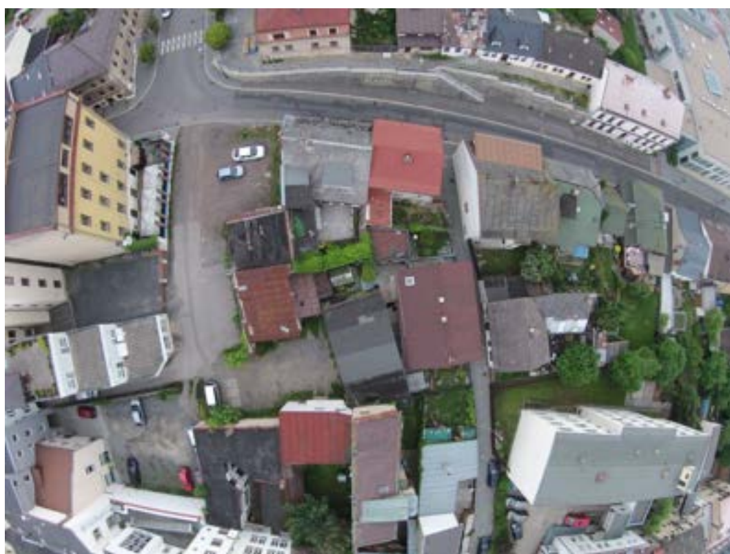
Zbořeniště domu č. p. 6 ve výřezu leteckého snímku, foto A. Kopecký 2015.
