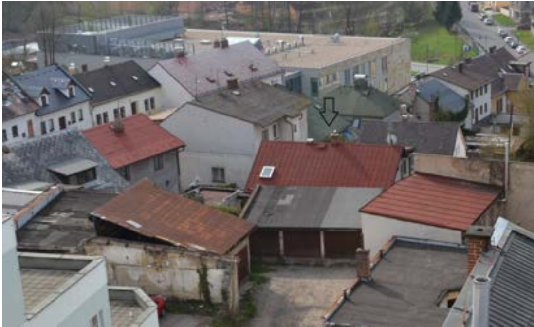
Pohled na střešní krajinu, dům č. p. 413 označen šipkou, foto TK 2013.
