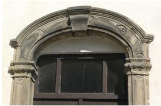
Detail segmentového nadpraží portálu, foto MK 2013
