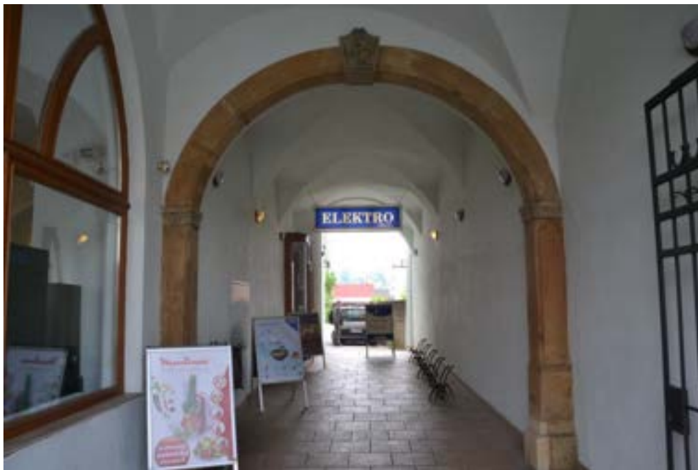
Pohled do průjezdu domu, portál odděluje komunikaci od zaklenutého přestavěného podloubí, foto IP 2013.
