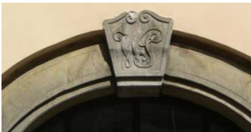
Detail klenáku na portálu hlavního vstupu, foto MK 2013.
