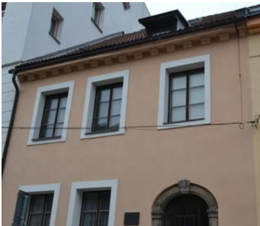
Patro hlavního průčelí, foto IP 2013.
