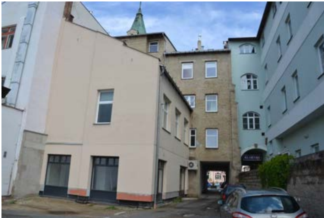
Dvorní jižní průčelí, foto IP 2013.
