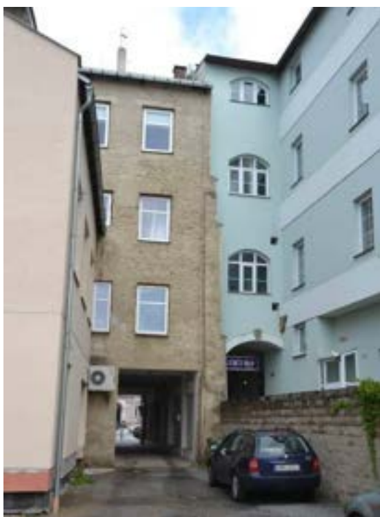
Dvorní průčelí s průjezdem, foto IP 2013.
