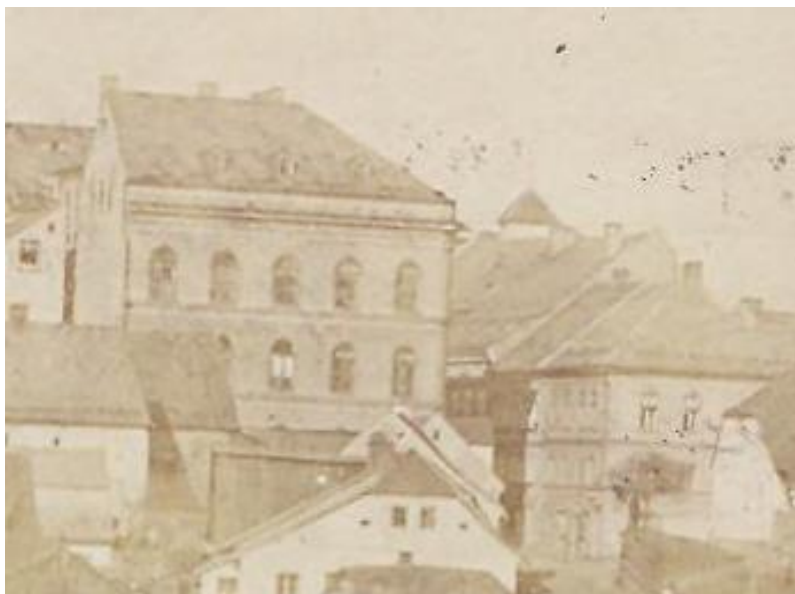
Zadní průčelí domu č. p. 5, u nároží této školy vystupuje štít a vikýř domu č. p. 6, výřez z celkového pohledu na Markovu ulici, 1. pol. 20. století, (foto sbírka MČR, inv. č. AFT 415).
