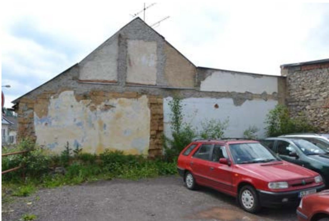
Štítové severní průčelí domu č. p. 7, zdivo ve spodní partii podlaží náleží zdemolovanému č. p. 6, domu č. p. 7 náleží především trojúhelný štít v druhém plánu snímku, vymezují ho ústupky ve zdivu, foto IP 2013.
