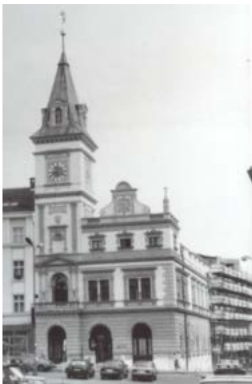
Přístavba radnice dům - č. p. 335 v době rekonstrukce v roce 1993, (foto sbírka MČR, inv. č. AFT 793 a).
