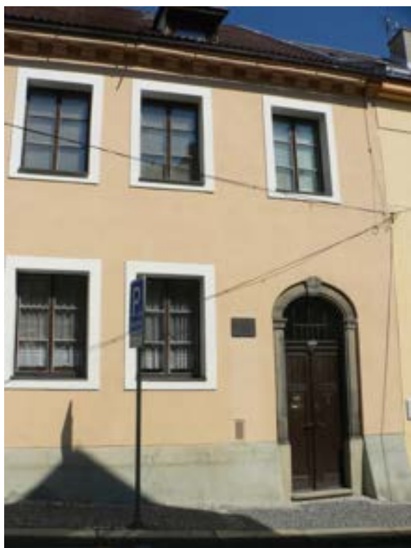
Hlavní západní průčelí domu č. p. 333, foto MK 2013.
