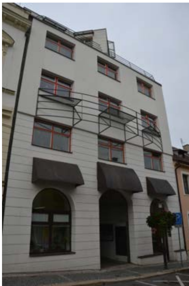
Dům č. p. 334, hlavní západní průčelí, foto IP 2013.
